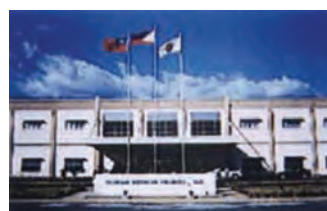
Hitachi Air Conditioning, Филиппины
